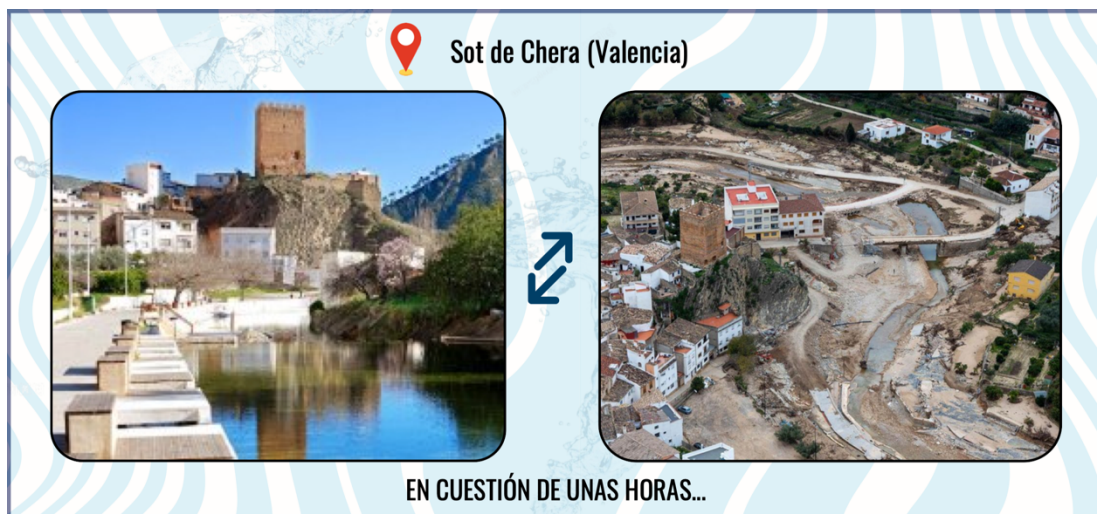
Figura 1. Imagen de Sot de Chera antes y después de la DANA (Oct 24).
