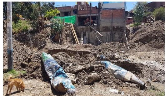
Fig 2. Desechos de construcción (7)
