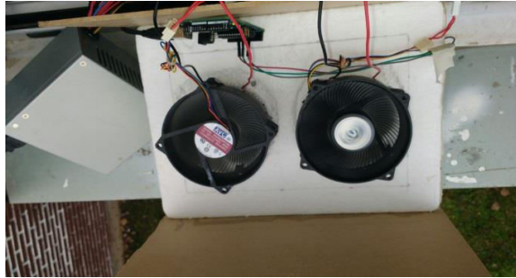
Imagen 3. Colocación de los ventiladores
